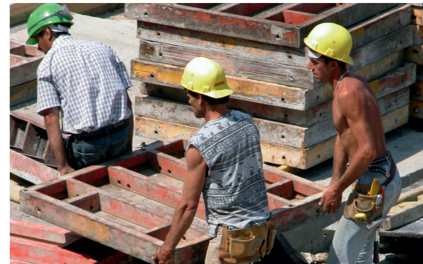
Bauarbeiter leiden unter hohen Belastungen.
